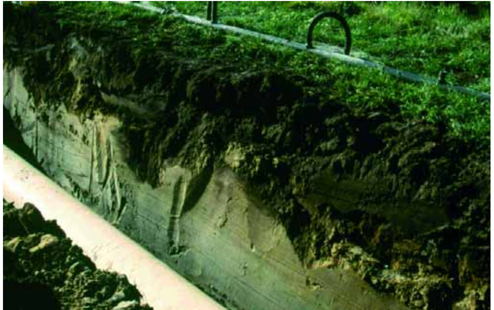
afbeelding 15, de ruim één meter diepe sleuf met onderin de persleiding.
